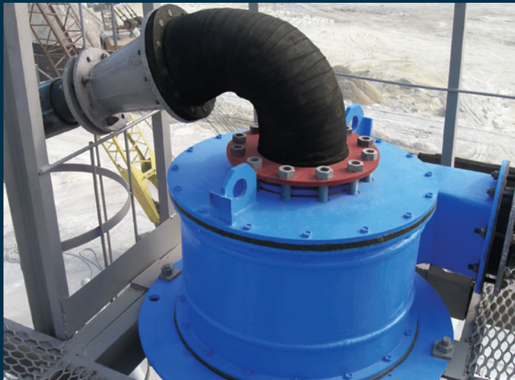
Установка резинового отвода в гидроциклоне
